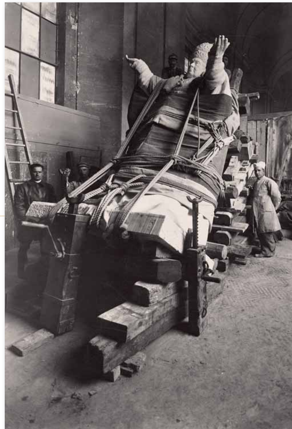
Lavori per la costruzione del monumento a Pio X in San Pietro
